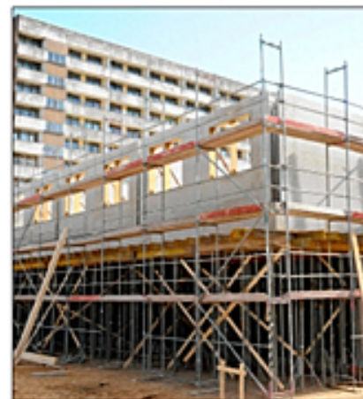
Das Internatshochhaus wird abgerissen, davor entsteht das neue.
