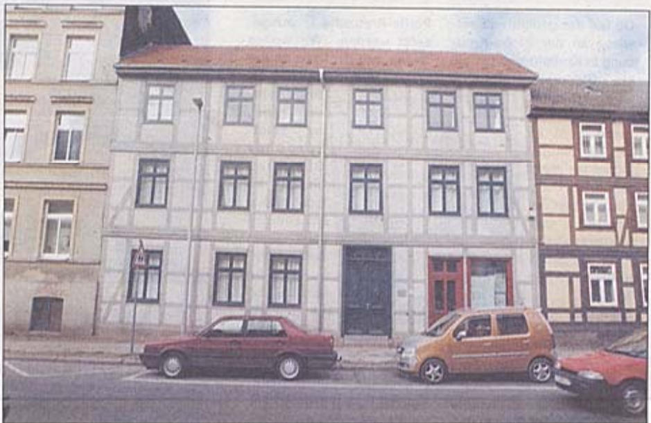
Werderstraße 73: Der Baupreis 2006 ging für die Sanierung des Hauses, die die historische Fassade erhielt und auf der Hofseite neue Bausubstanz einfügte, an das Ehepaar Schulz.
